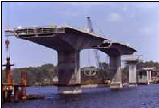
Fig. 9.4. Puente Sagadahoc, Maine.
