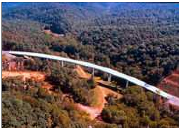
Fig. 9.2. Puente Happy Hollow, Tennesse, USA.
