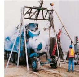
Fig. 13-1. El nitrógeno líquido, adicionado directamente en el camión mezclador en la planta de concreto premezclado, es un método eficiente de reducción de la temperatura del concreto durante la colocación en clima caluroso o en la colocación del concreto masivo. (IMG12357)
