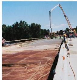
Fig. 12-1. El curado debe empezar en cuanto el concreto se endurezca suficientemente para prevenir la erosión de la superficie. El yute (arpillera, estopa) rociada con agua es un método efectivo para el curado húmedo. (IMG12363)
