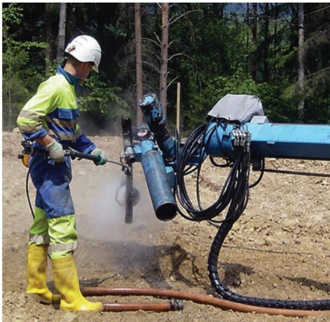
Figura 8.28 Limpieza del equipo de shotcrete.
