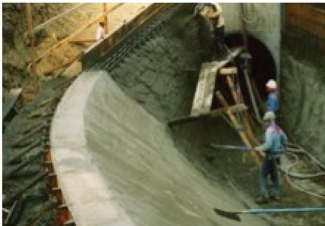
Figura 1.8 Hormigón proyectado en un canal hidráulico.
