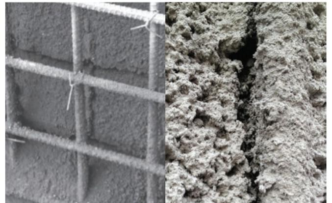
Figura 8.6. Ejemplos de una proyección donde ha quedado mal encapsulada la enfierradura.
