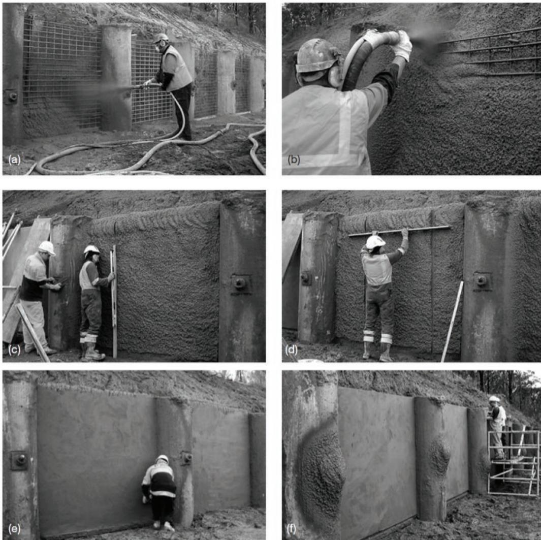
Figura 8.19 Proceso de proyección en muro vía shotcrete manual.
