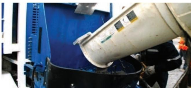
Figura 12.10 Carga de hormigón en "bomba".
