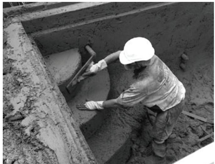
Figura 8.20 Construcción de una piscina con hormigón proyectado.
