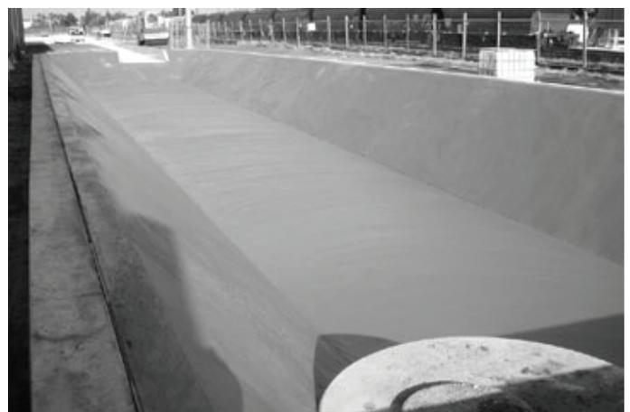
Figura 9.21 Construcción de canal con hormigón proyectado.
