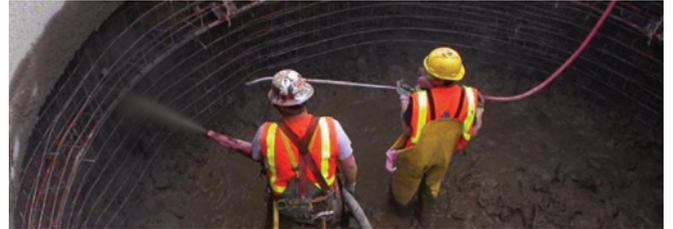
Figura 4.3 Aplicación de shotcrete sobre malla.
