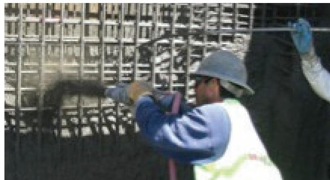
Figura 2.2. Shotcrete a través de varias capas de armadura en un muro.
