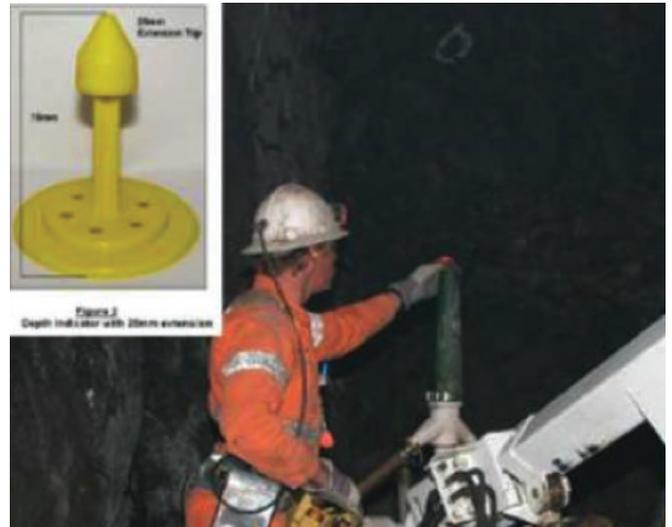
Figura 8.27a Control de espesor. Puntas adheridas al sustrato.
