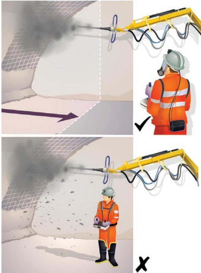
Figura 12.4 Posición del operador durante la proyección. Fuera del área de rebote y con equipo de protección personal adecuado.
