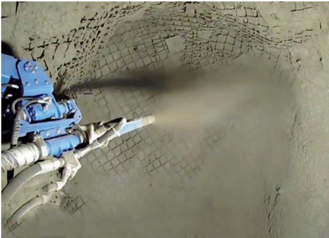
Figura 1.6a Shotcrete sobre perno y malla.
