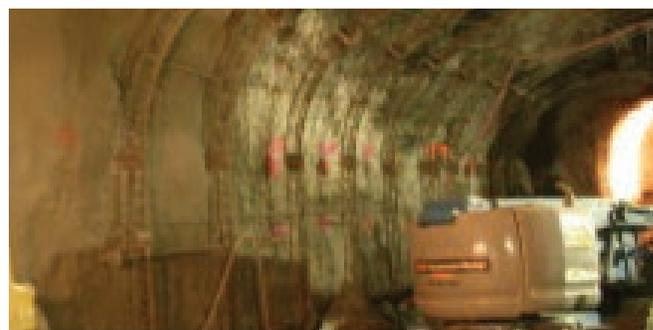
Figura 2.3. Shotcrete a través de secciones de marcos reticulados estructurales.
