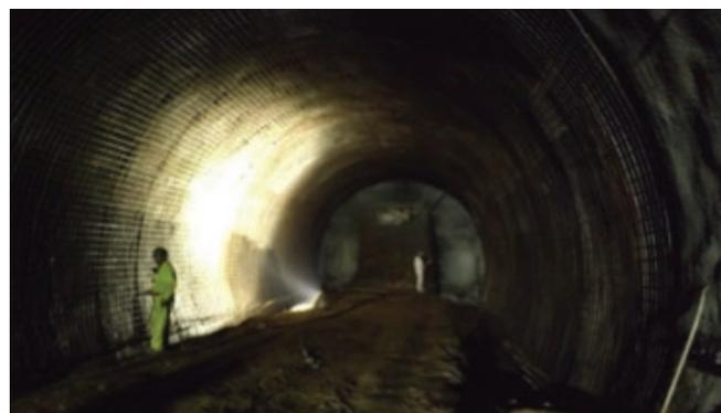
Figura 12.11 Fortificación de un túnel.
