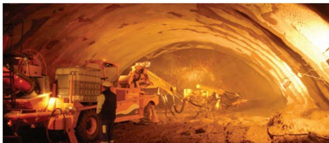
Figuras 1.5 Cavernas revestidas con hormigón proyectado.
