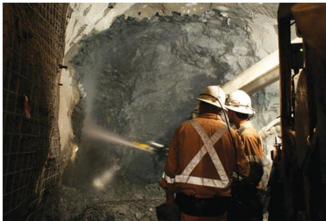
Figura 1.4 Shotcrete en Túnel.
