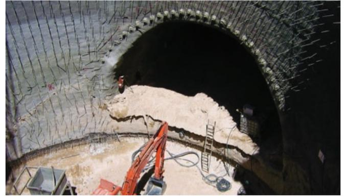
Figura 1.16 Pique de acceso a construcción de túneles y galerías Metro de Santiago, 2003.
